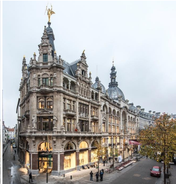
Photo après la restauration (déc. 2014)
