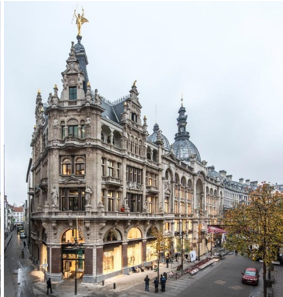
Foto na de restauratie (dec. 2014)
